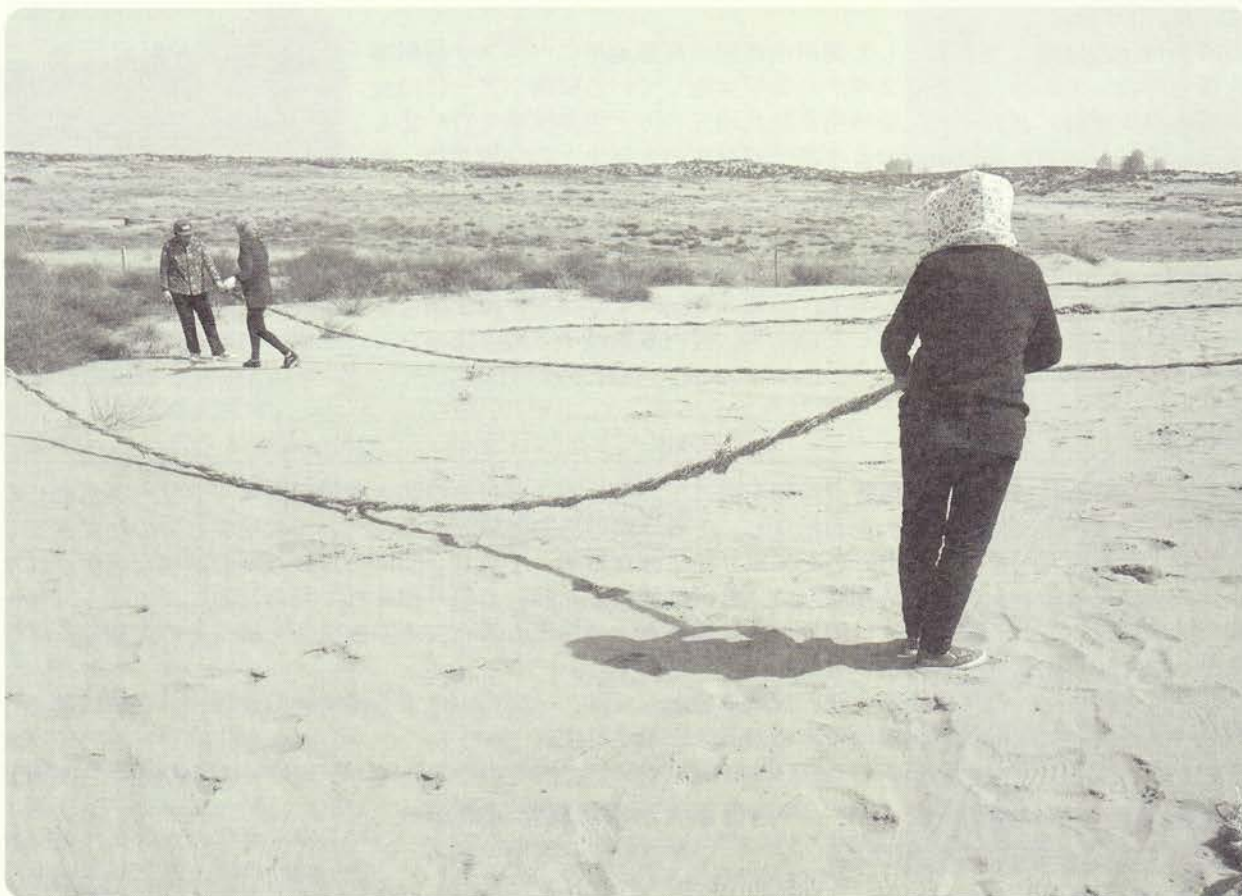
沙障の設置作業
